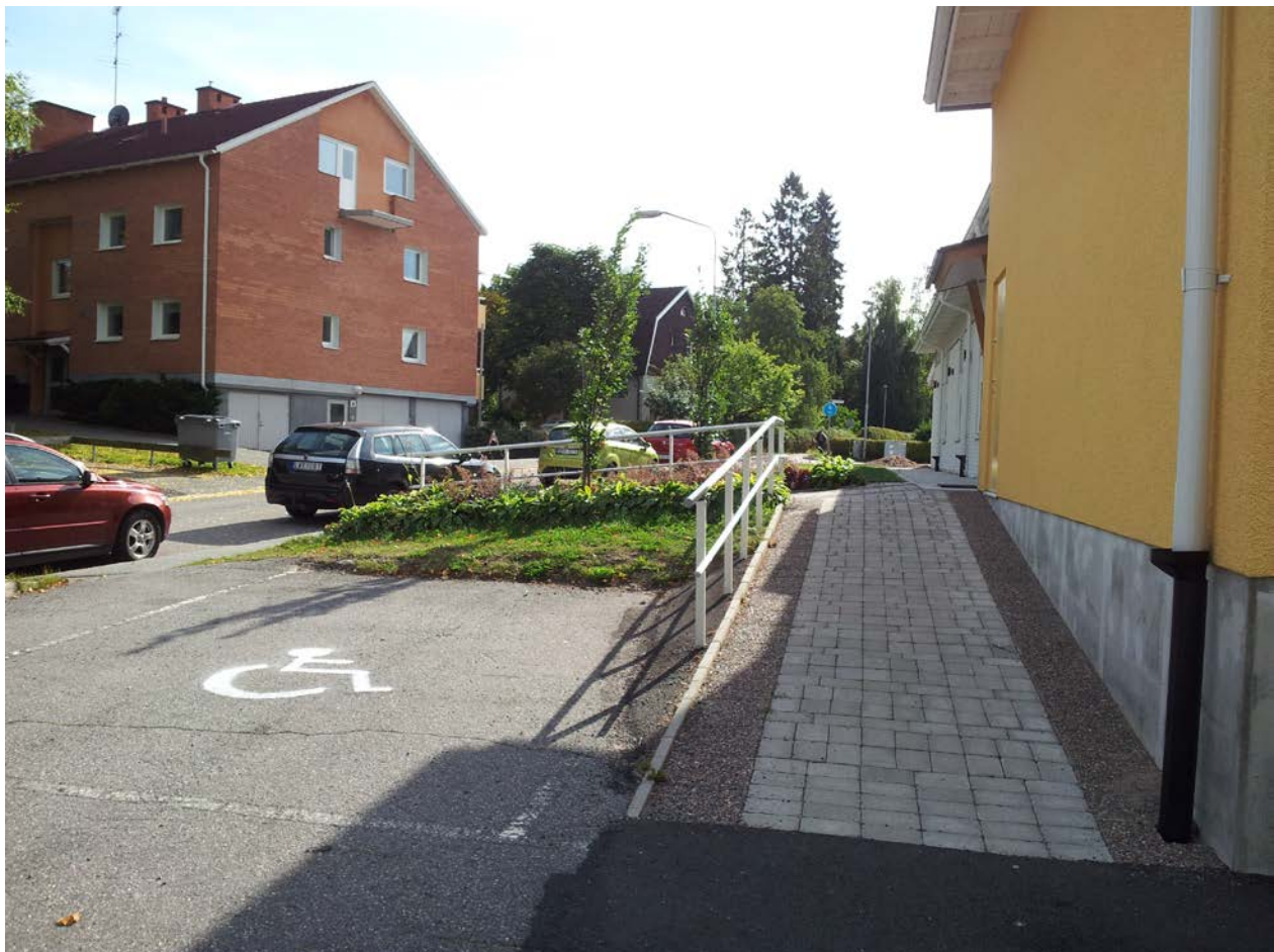
Tillgänglighetsanpassad entré till byggnaden på Kalkonen 8
