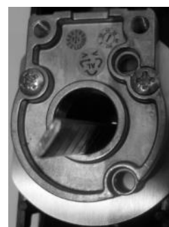
Figur 6.5 Vredets monteringsplatta för Abloy 4000
